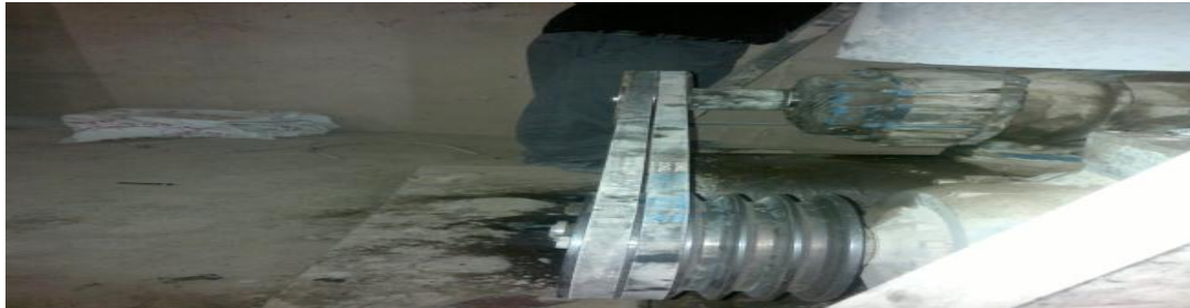
شکل ۷-مربوط به تنظیم نبودن تسمه ها
